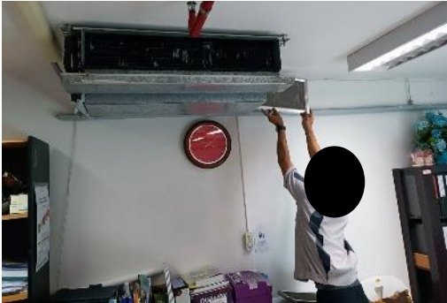
ภาพที่ 2.2-18 การล้างทำความสะอาดเครื่องปรับอากาศ
