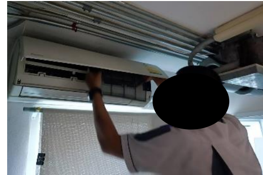
ภาพที่ 2.2-18 การล้างทำความสะอาดเครื่องปรับอากาศ
