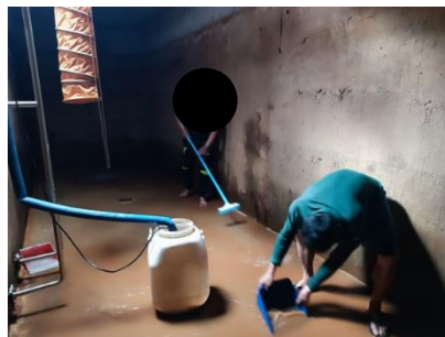
ภาพที่ 2.2-18 การล้างถังเก็บน้ำชั้นใต้ดินและชั้นดาดฟ้า
