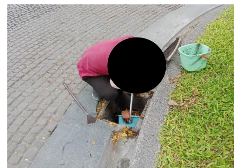
ภาพที่ 2.2-12 การทำความสะอาดราง/ท่อระบายน้ำ
